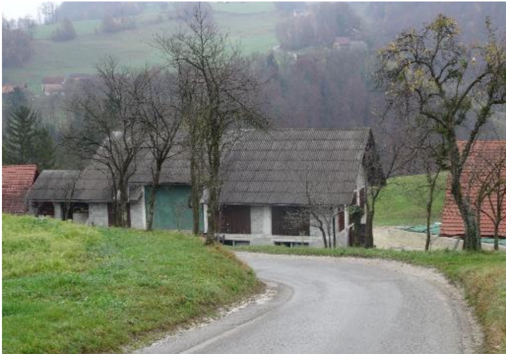
Slika 21: Nevaren odsek št. 3
