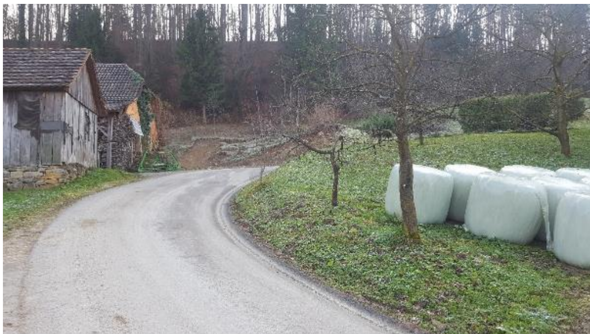
Slika 24: Nevarni odsek št. 5
