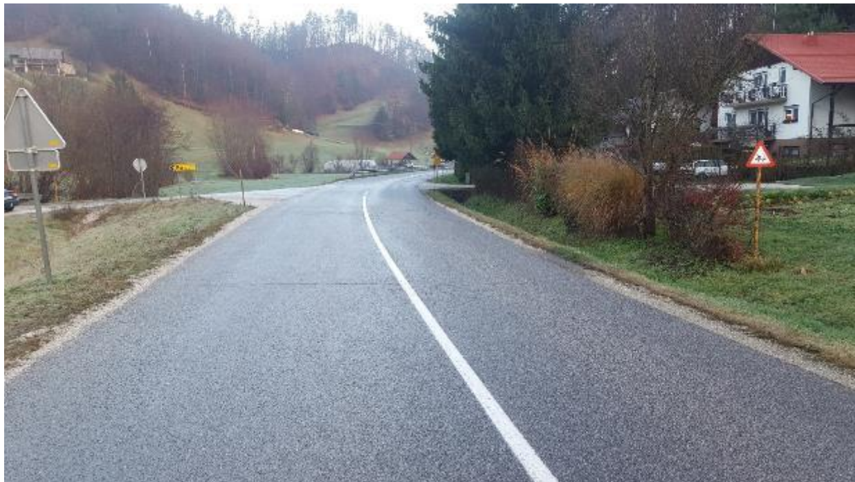
Slika 26: Nevaren odsek št. 6 avtobusna postaja Stopa
