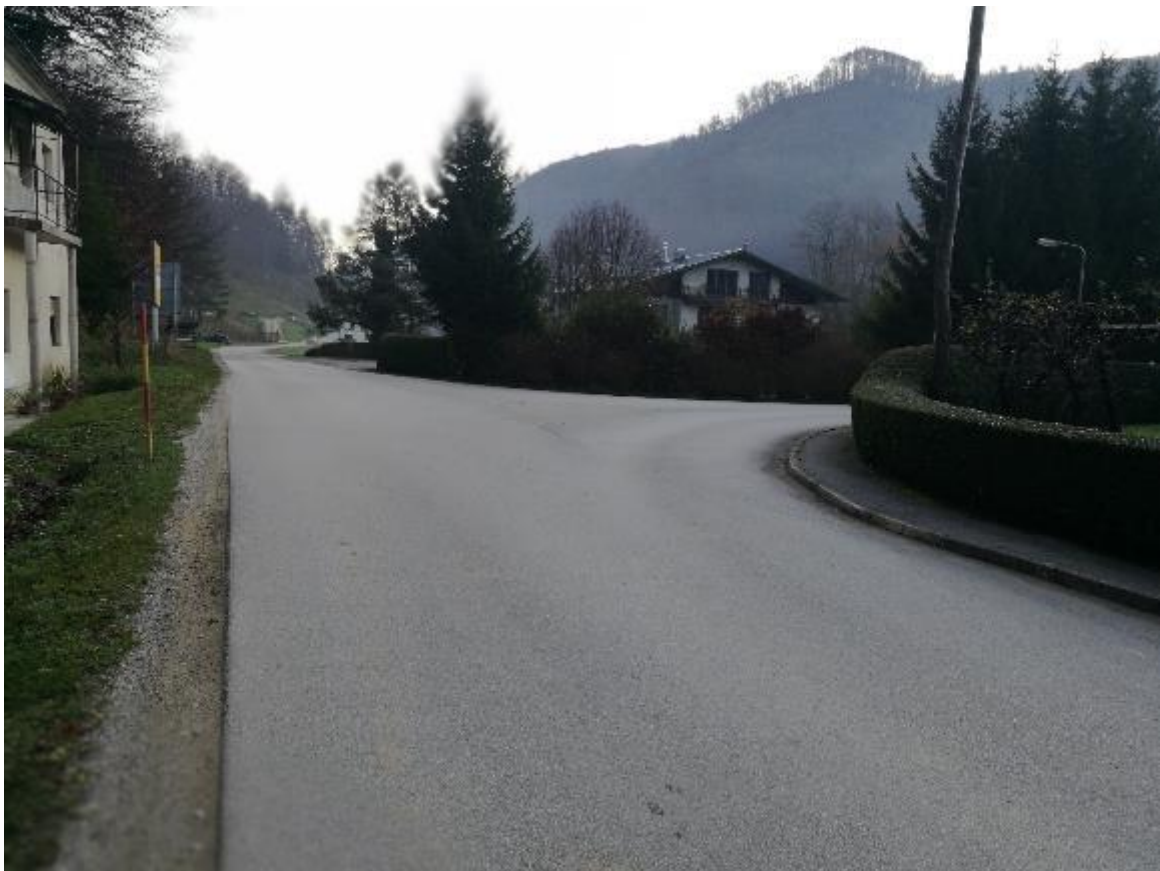
Slika 28: Nevarni odsek št. 7
