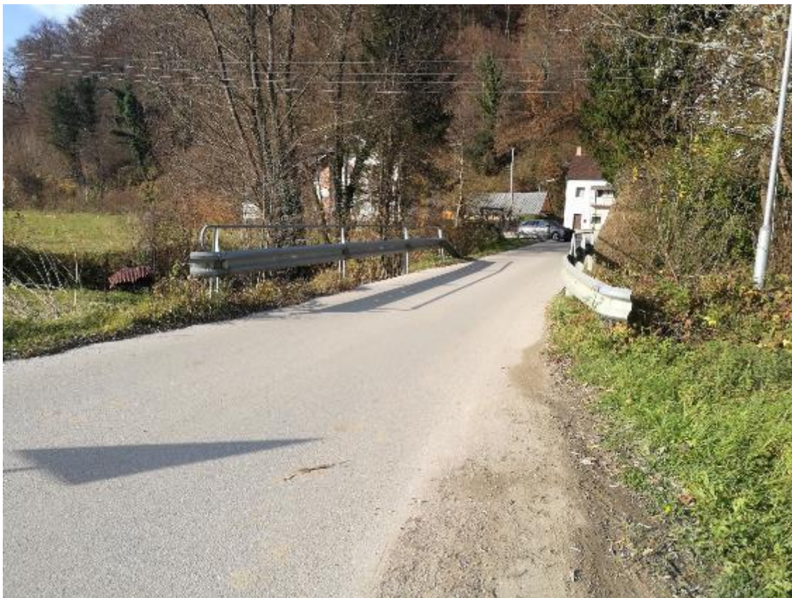
Slika 29: Nevarni odsek št. 8
