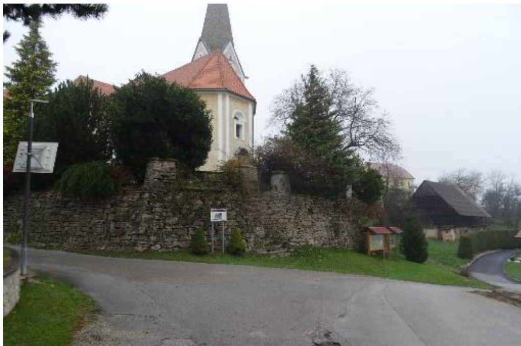
Slika 22: Nevarni odsek št. 4
