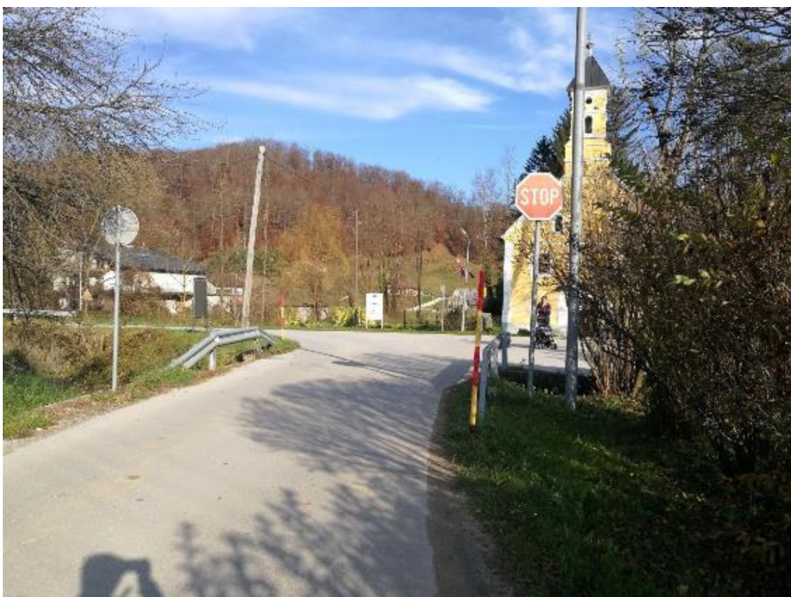
Slika 30: Nevarni odsek št. 9
