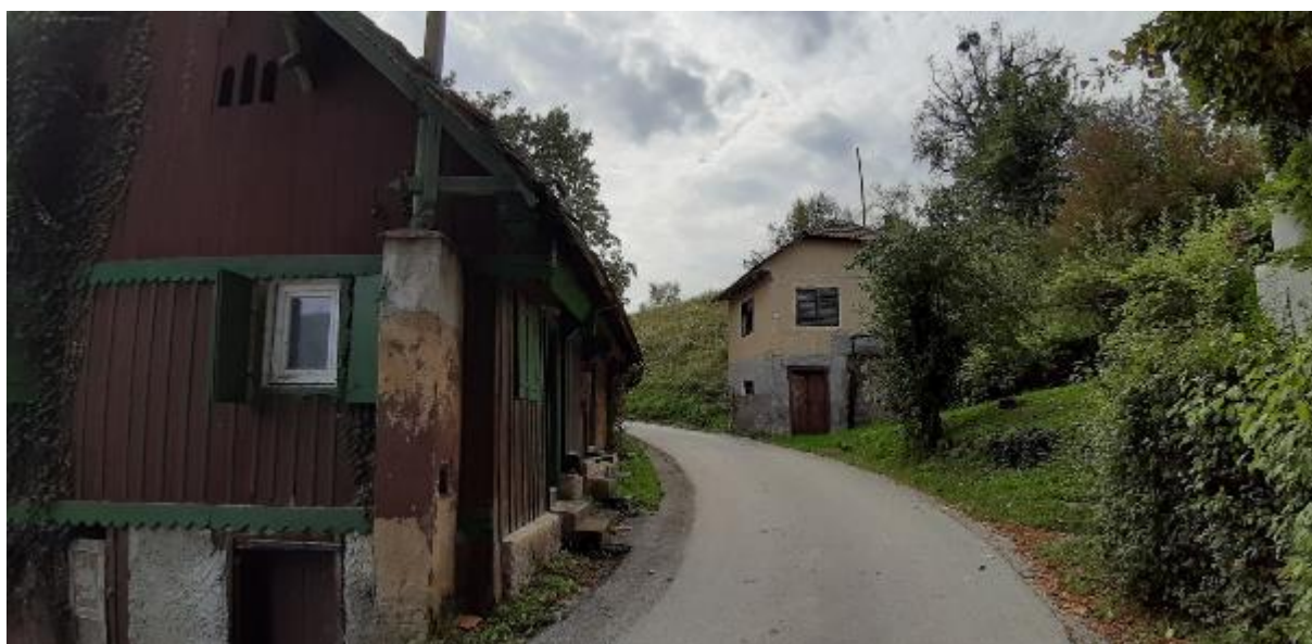
Slika 33: Nevaren odsek št. 11
