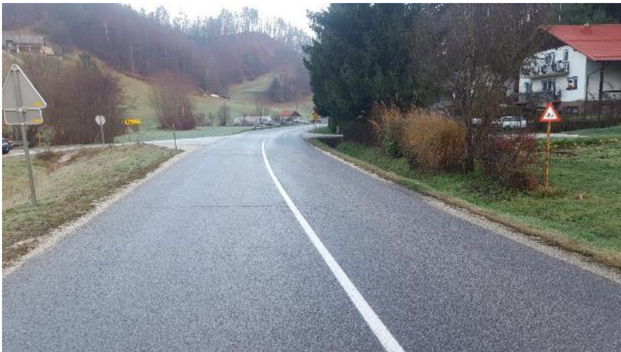
Slika 29: Nevaren odsek št. 6 avtobusna postaja Stopa
