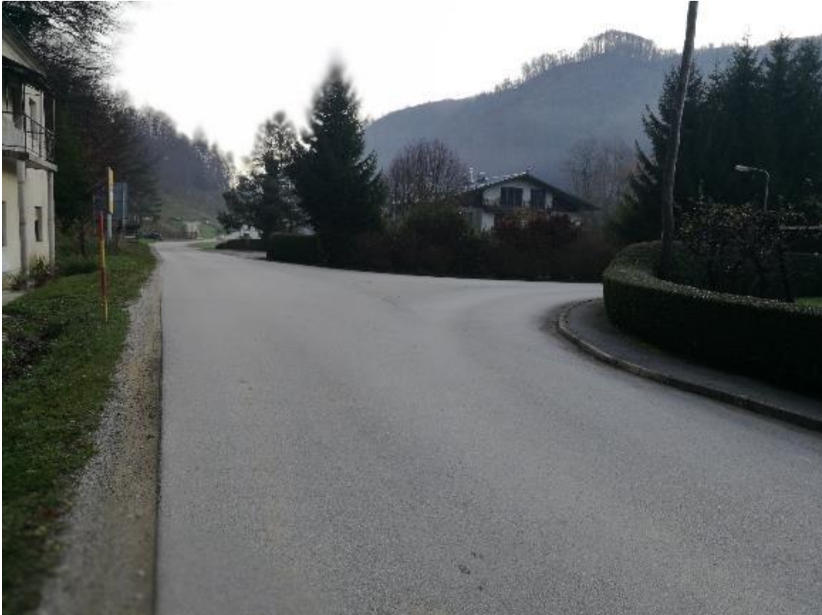
Slika 31: Nevarni odsek št. 7
