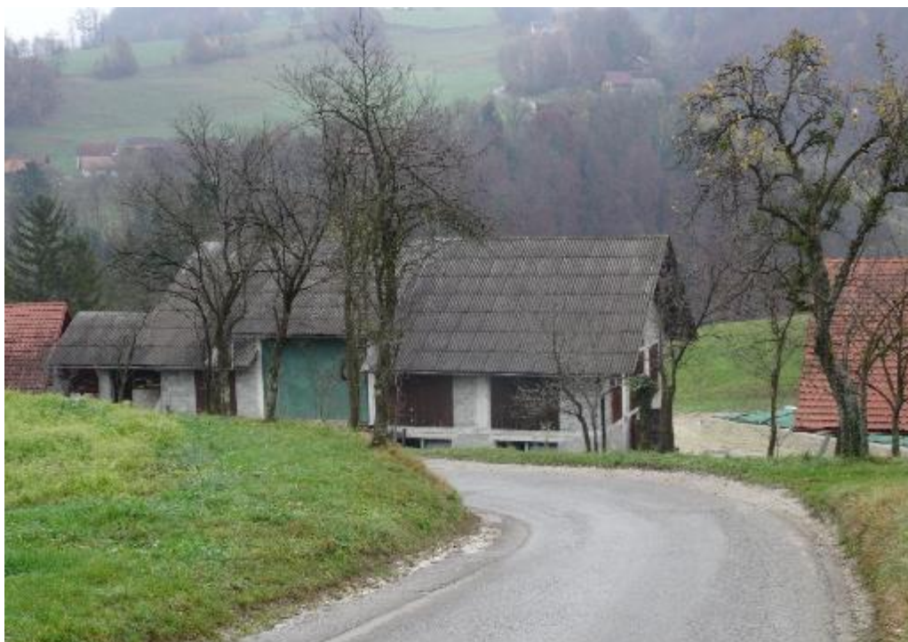
Slika 24: Nevaren odsek št. 3
