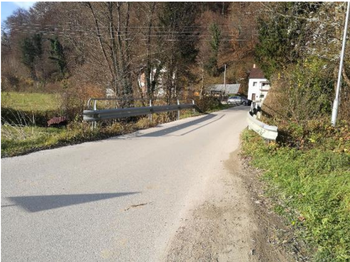
Slika 32: Nevarni odsek št. 8
