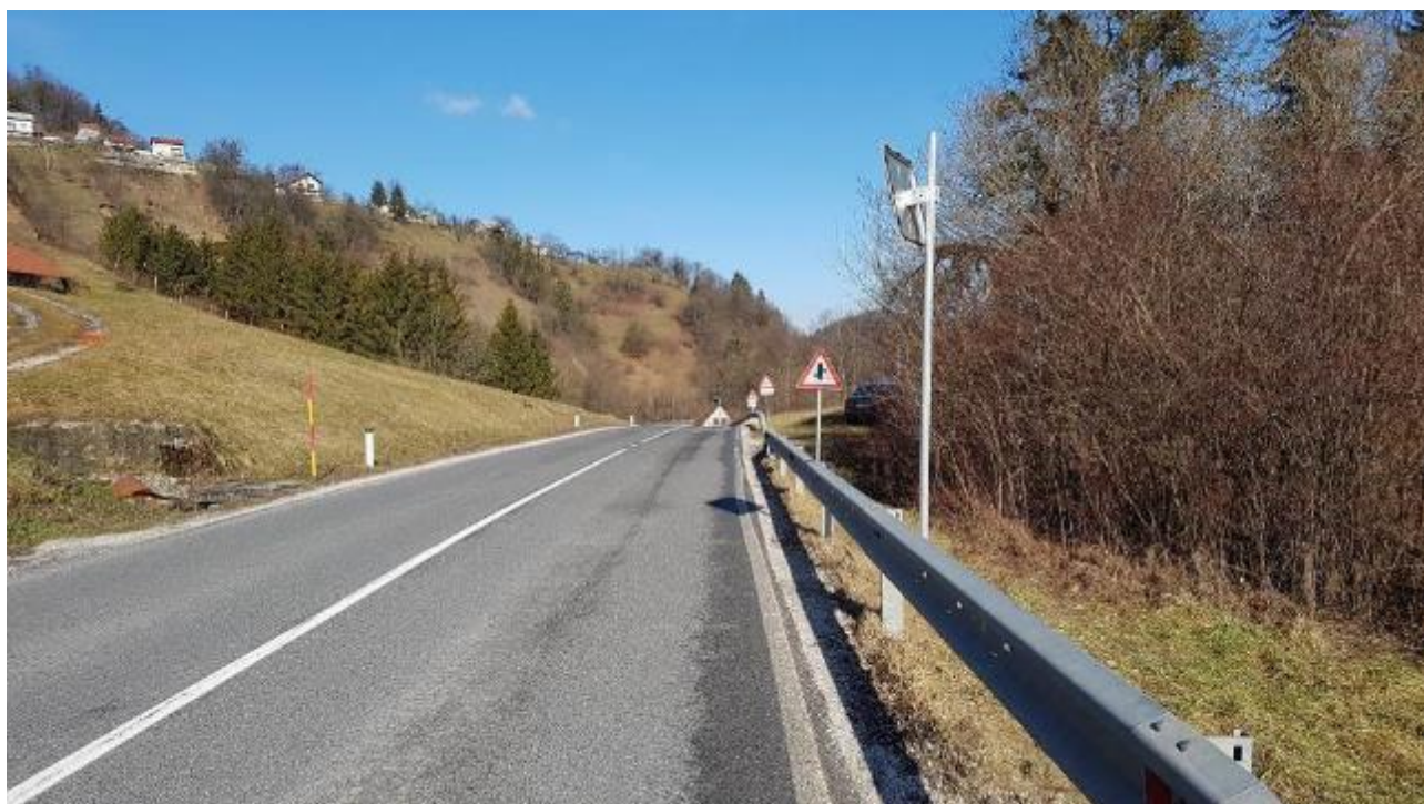
Slika 44: Nevaren odsek št. 15
