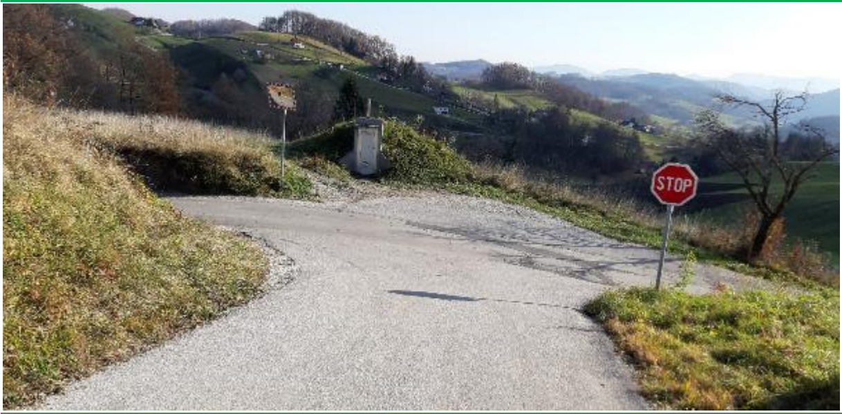
Slika 37: Nevaren odsek št. 12
